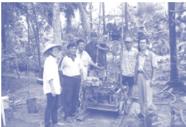
[写真5] メコンデルタにおける機械ボーリング調査
