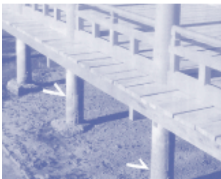
〔図3〕 厳島神社床下柱の根継ぎ
