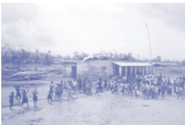
[写真4] サイクロンで破壊されたガンジス川河口部Sandwip島の小学校
