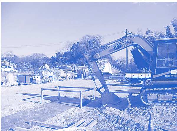
【写真2】グズグズと進められている工事現場(2005年2月22日撮影)
