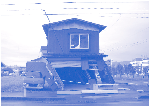
【写真2】傾斜する木造車庫(2階は小部屋)
