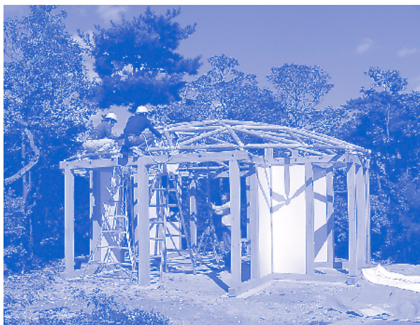
三木山森林公園東屋(我々が開発した木造トラスシステムによる最初の建物、屋根形式は単層楕円ドームで、写真は膜屋根を外して、部材の交換実験を行っているところ)
