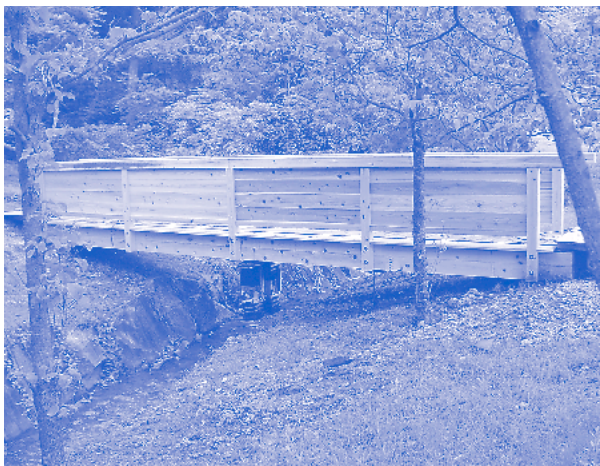
同じ三木山森林公園に設置された人道橋（スパン7mの単純桁橋、写真は径間中央に加振器を設置し、加振実験をおこなっているところ）
