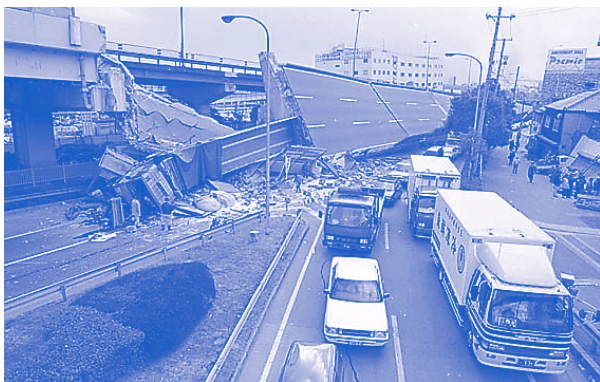
崩れた国道43号岩屋高架橋から落ちたトラック(撮影者:前田耕作:神戸大学附属図書館「震災文庫」提供)
