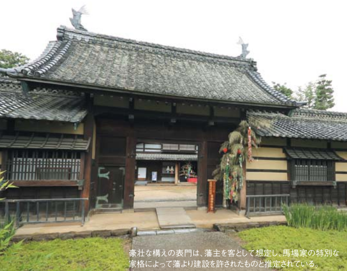
棟の正面に「雀おとし」と呼ばれる棟飾りを付けた、長野県西南部に分布する本棟造と呼ばれる民家の典型的な様式。右手に見えるのが中門。藩主が馬場家を訪れるときのみ開けられる。
