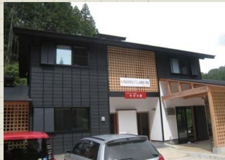
都市と農山村の交流拠点施設「すげの里」。 愛知県産材を使った木造2階建て。太陽光パネル、薪ストーブ、薪ボイラーなどを導入した自然エネルギーを体験する施設。本田さんは、地域で採れた材を丸太のまま燃やして風呂などの給湯および床暖房に利用できるウッドボイラーの開発、普及に向けて研究をすすめています。
