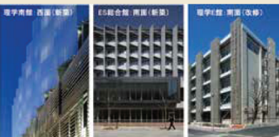
建築的工夫による省エネ対策：日射遮蔽材の設置例
