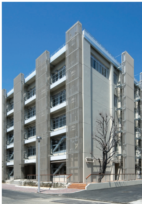
理学部E館：南面（改修）
